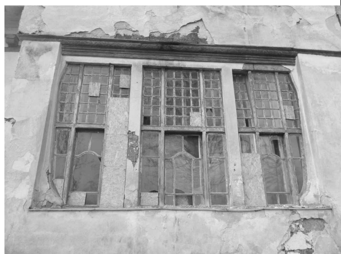
Združená secesná trojdielna 18-krídlová okenná výplň v centrálnom rizalite východnej fasády. Zhora lemovaná kordonovou drevenou rímsov s polychrómovanou drevorezbou.
